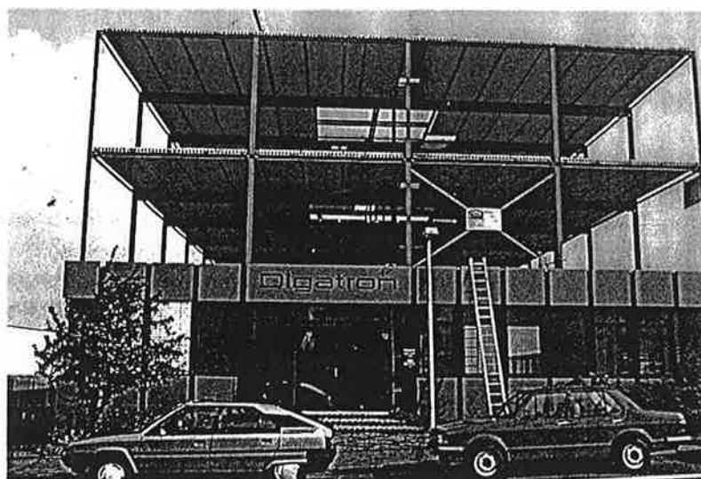
DES ELEMENTS ALVEOLES PRECONTRAINITS DANS UNE STRUCTURE METALLIQUE./HOLLE VLOERELEMENTEN IN VOORGESPANNEN BETON IN KOMBINATIE MET EEN METAALSTRUKTUUR
