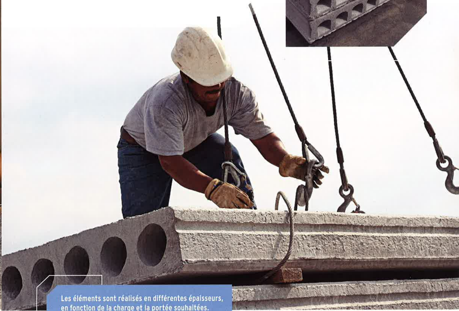
Les éléments de plancher alvéolés en béton armé
